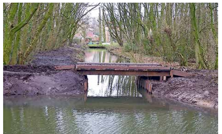
Ten zuiden van het opgeschoonde populierenbos in het Lammetjeswiel is een eenvoudig voetgangersbruggetje geplaatst om de doorstroming te verbeteren.
